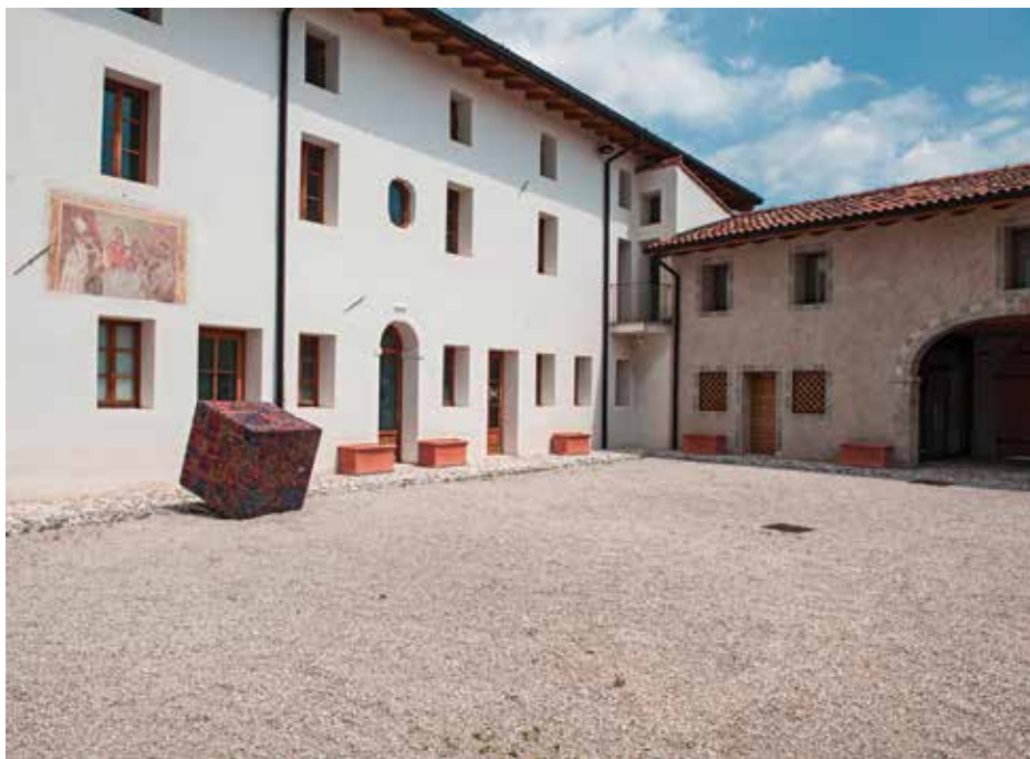
Corte di Palazzo Toffoli - Foto di Danilo Rommel
